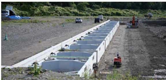
写真2. 建設した屋外水槽。写真右側にさらに屋外水槽が三列、左側には飼育用水の昇温のための貯水池が建設される予定である。
